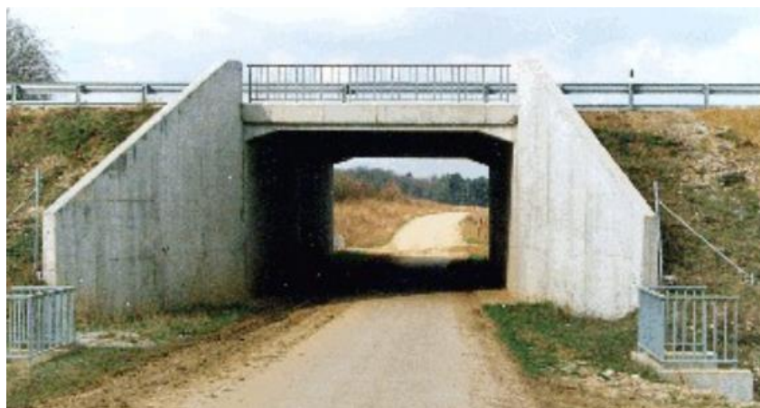
Passage inférieur à cadre fermé
